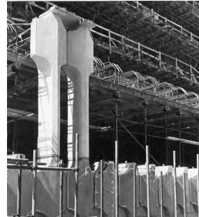
Montaje de las piezas prefabricadas de fachada Assembling the prefabricated pieces on the facade
